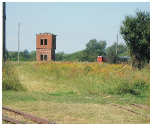
Kierownictwo ciuchci chce remontować wieżę w Umianowicach.
